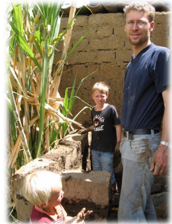
Arbeiten mit Adobe
